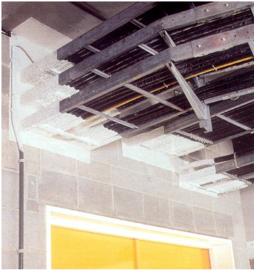
Plattenabschottung
